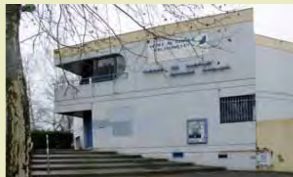
Le bâtiment sera démolé et un nouveau verra le jour, toujours au Village 2, fin 2012.
