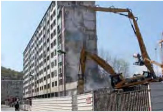
Après le bâtiment J l'été dernier, c'est au tour du bâtiment K d'être grignoté par les mâchoires des engins de chantier. Un chantier hautement spectaculaire.
